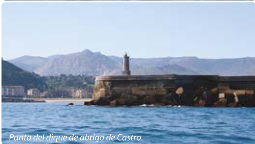
Punta del dique de abrigo de Castro
